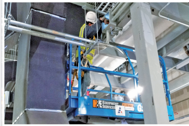
Steel Conduit Installation
